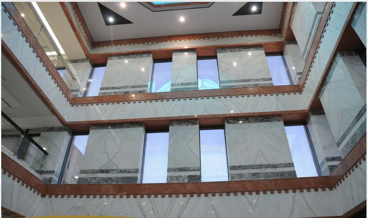
Aluminum works | أعمال الألمنيوم
